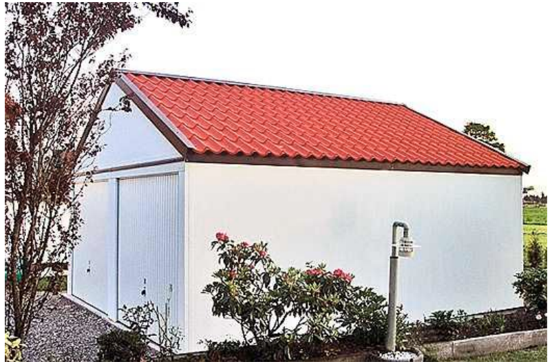
Gut belüftete MC-Garagen in Preisbrecherqualität
