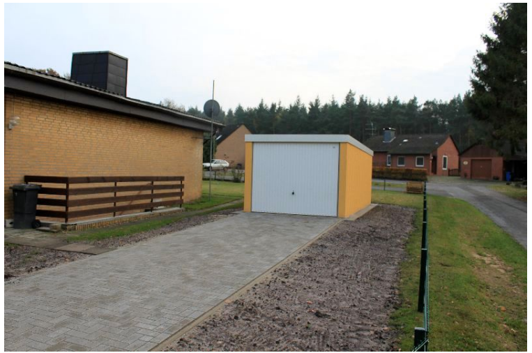
Schutz vor Wetter und Unbefugten mit Garagenrampe.de
