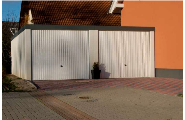
Garagenbau vom Feinsten: Garagenrampe.de
