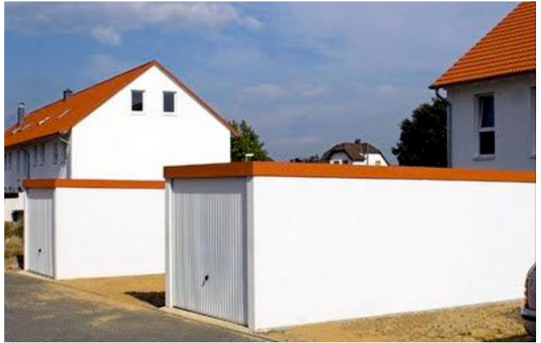
MC-Garagen: Garagenwände für Kunst am Bau
