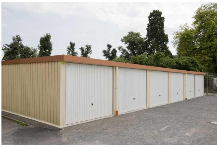
Sanft und staubarm belüftet mit Garagenrampe.de
