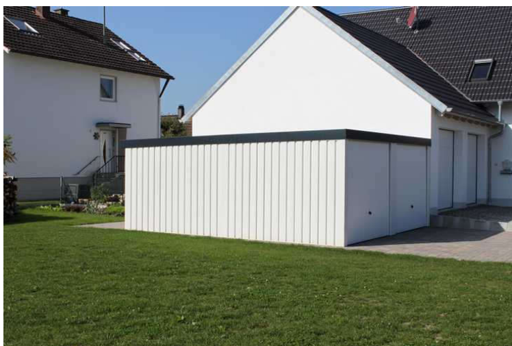
Zusätzliche Garagenplätze von Garagenrampe für Oldtimer
