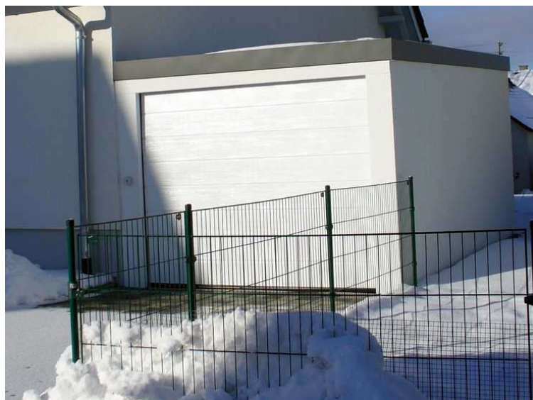
Bedachtsamer Garagenbau mit Garagenrampe.de
