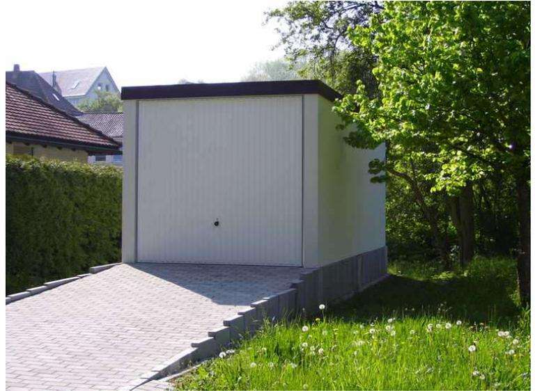
Erhöhtes Fundament als Hochwasserschutz
