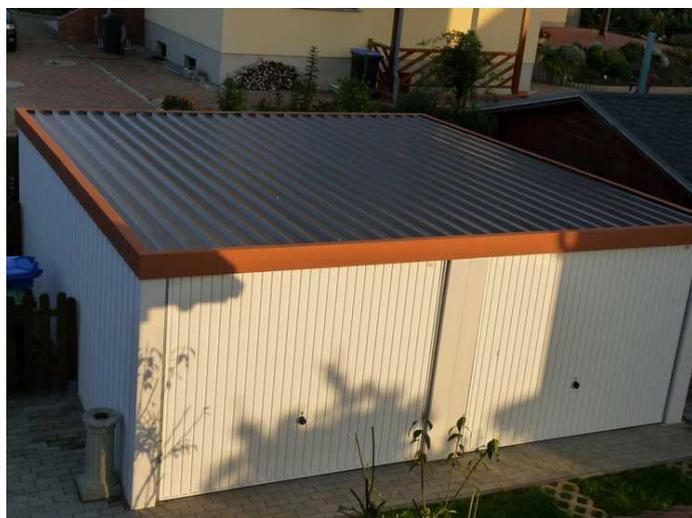
Trockenes Garagendach dank Gefälle, Dachrinne und Fallrohr
